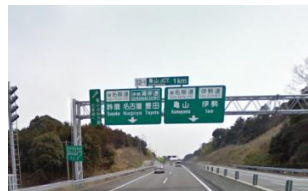
写真-1 23.7kp 地点 (亀山 JCT 手前 1km)
