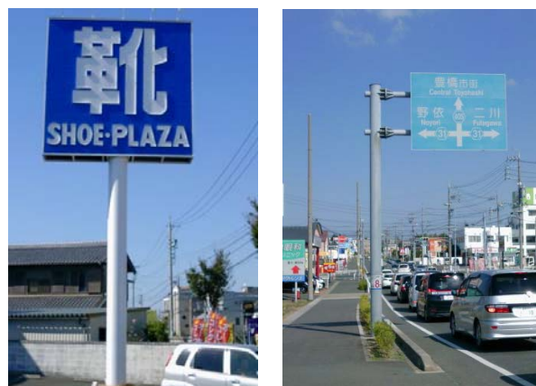
写真-1 直立式看板(左)と片持ち式交通標識(右)
