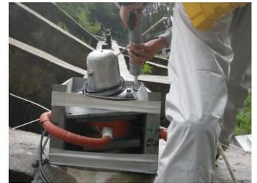
写真-3 温度計設置状況
