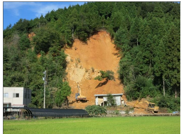
図-1 越前町八田の斜面崩壊の全景
