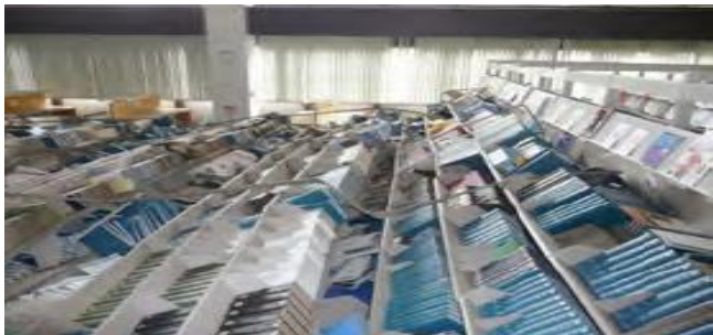
写真-1 東北地方太平洋沖地震における書架の転倒 1)
