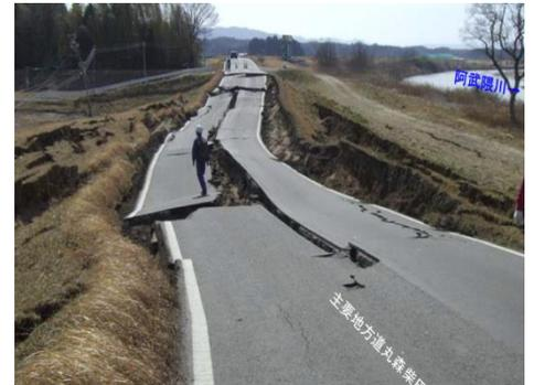
写真 1 河川堤防の変状被害
