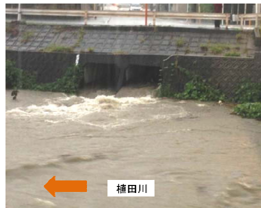
写真-2 出水時の雨水吐流出状況 (2013年9月4日)
