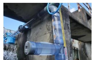
(b) 鉛直部に設置した止水域
