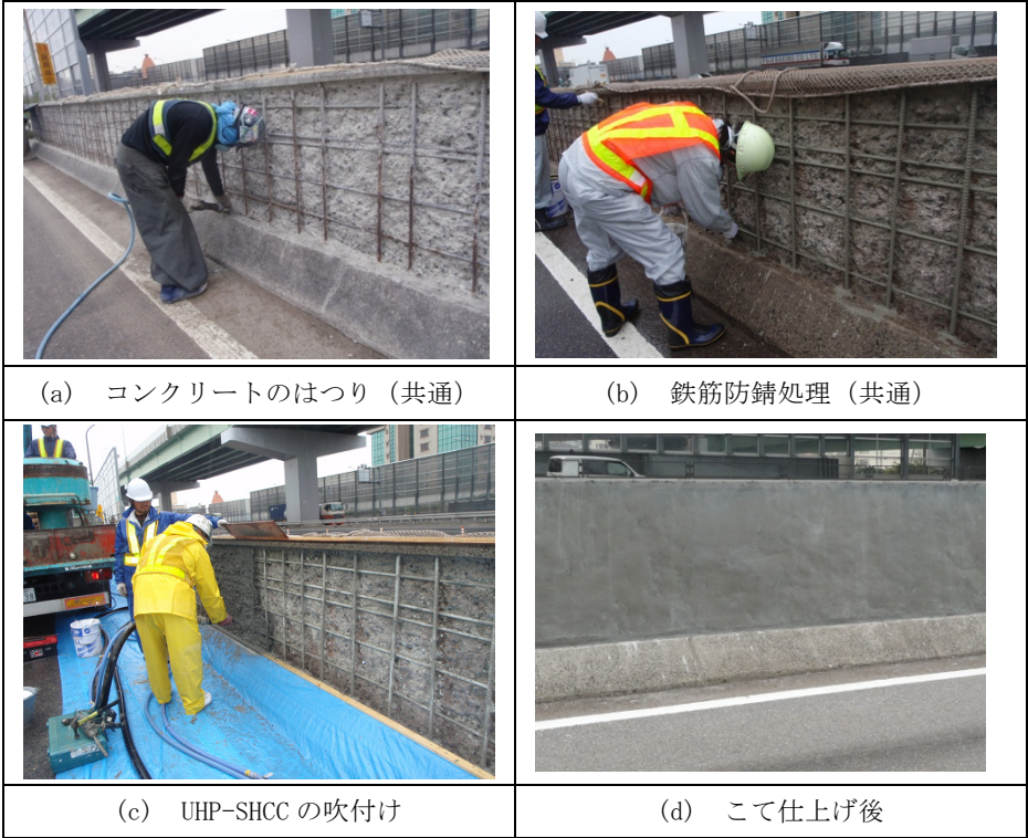
図-2 各工程の状況（UHP-SHCC を用いたハイブリッド表面保護工）
