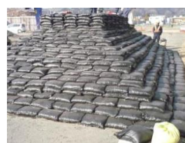
写真-1 ソルパック試験施工
