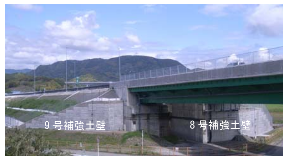
写真-1 工事完了全景
