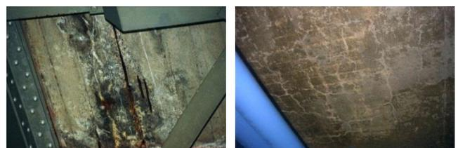
図-1 損傷写真例(左: 中酸化, 右: 疲労)
