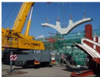
写真-3 半割アーチ梁部材建込み
