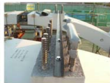
写真-6 架設後 固定状況 2
