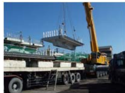
写真-4 横梁・スラブ部材建込み
