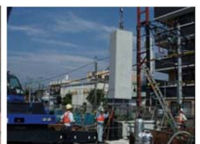
写真-2 スタンド部材建込み
