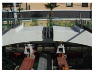
写真-5 架設後 固定状況 1
