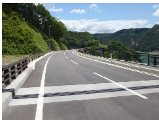
写真-3 路面状況
