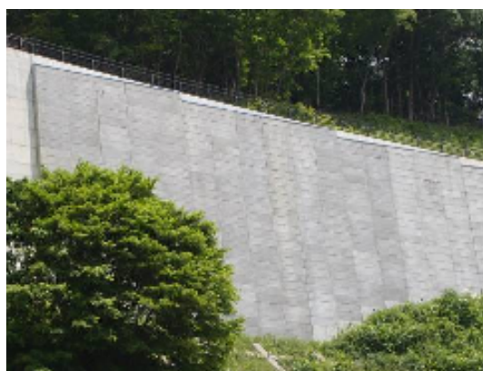
写真-2 壁面状況
