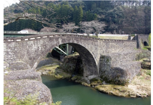
写真-1 霊台橋（スパン 28.36m, 拱矢 14.18m, 拱厚 0.9m）
