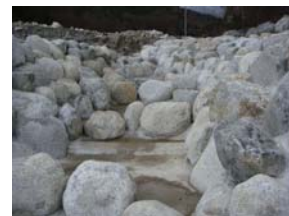
写真-2 施工完了全景
