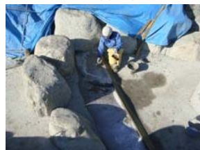
写真-1 施工状況
