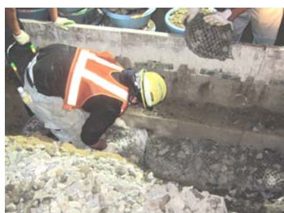
写真5 ジオテキバッグの敷設
