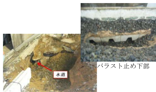
写真3 掘削後の状況(2)
