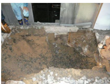
写真2 掘削後の状況(1)
