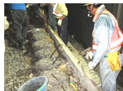
写真6 鉄筋の打設
