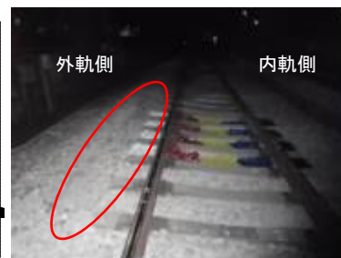
写真-3 現地施工
