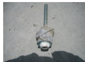
写真-9 突起羽残存状況
