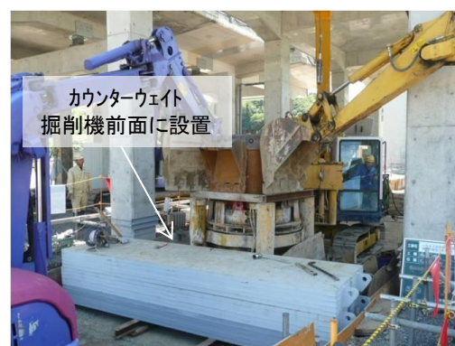
写真-2 カウンターウェイトの設置状況
