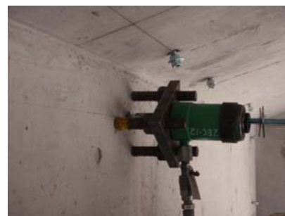
写真－３ 引き抜き試験状況
