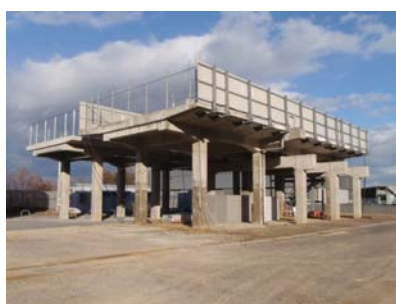
写真-1 実物大ラーメン高架橋
