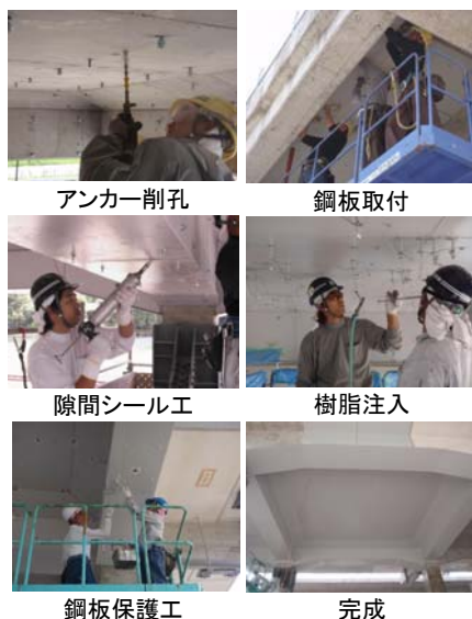
写真－２ 施工状況
