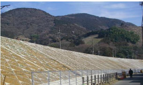
写真-1 プレキャスト格子枠工
