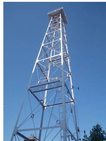
写真-1 火の見櫓の外観
