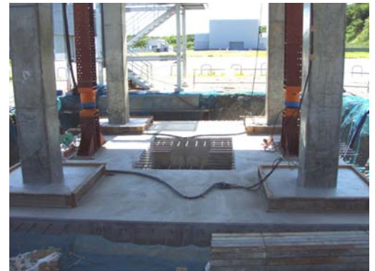
写真-1 基礎補強
