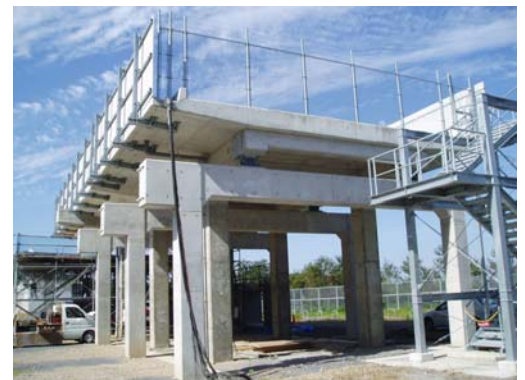
写真-2 縦梁補強
