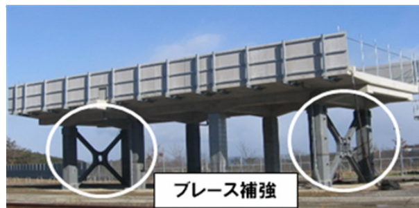
図-1 高架橋変位対策(ブレース補強) 1)
