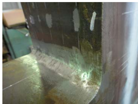
写真-2 三線交差部の溶接ビード仕上げの様子
