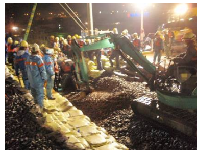
写真-2 バラスト撤去状況
