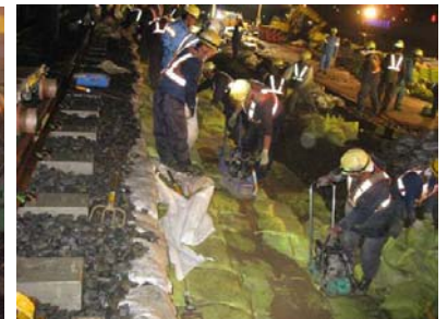
写真-3 土のう設置状況
