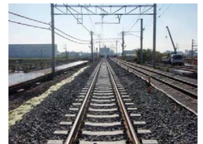
写真-4 切換完了全景
