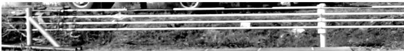
写真-1 繊維ロープ製車両用防護柵
