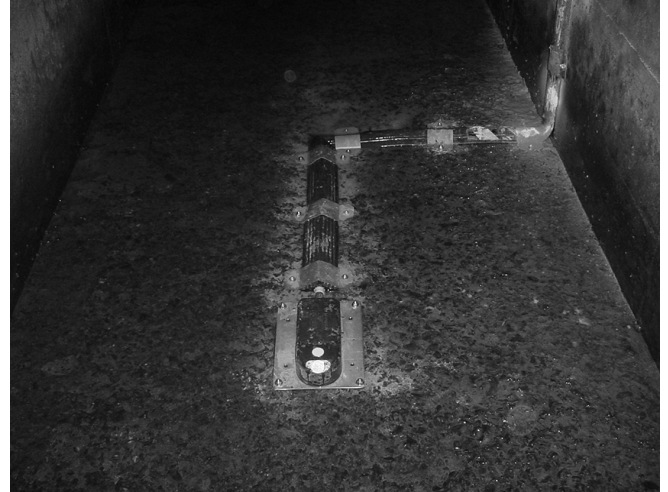
写真 1 ADCP 取付状態
