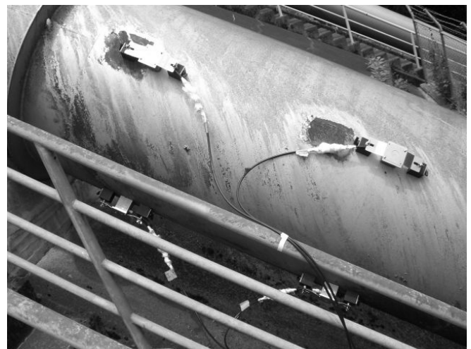
写真 2 超音波法計測状況
