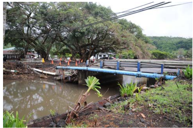
写真-2 Leoneにおける橋梁添架管の仮復旧状況
