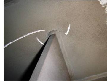
図-1 垂直補剛材上端近傍の疲労き裂
