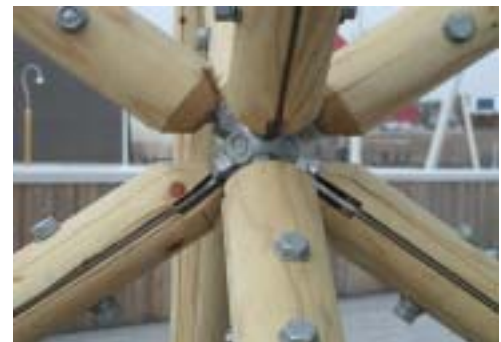
図-3 ボールジョイント接合部
