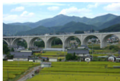
図2 上田ローマン橋 日中
