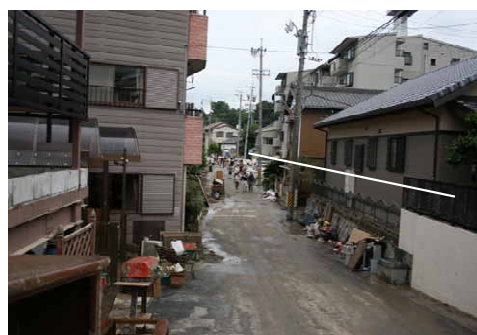
写真-2 伊賀町(2008/08/29,白線水位痕跡)
