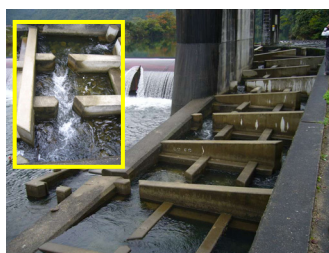
河東統合頭首工(揖保川)
