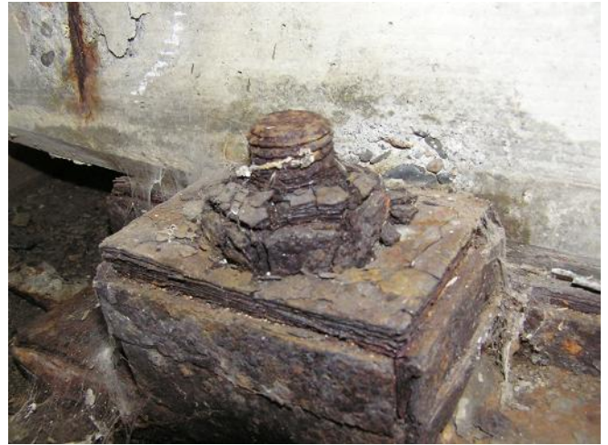
図1. 支承ボルトの経年劣化による破損
