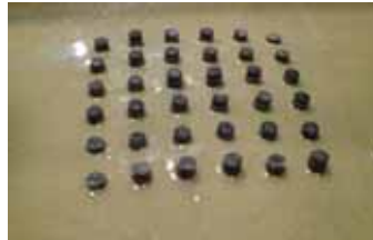
写真-4 内回り打設
