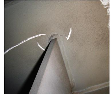
図-1 垂直補剛材の疲労き裂
