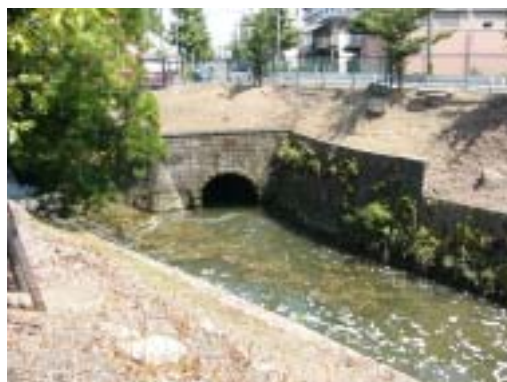
写真 1 導水箇所（猿投橋付近） 1)
