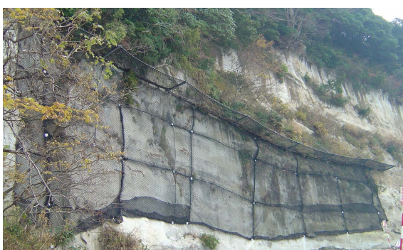
図-6 上部は角型鋼管支柱に PE ネットを支持させた事例、下部は覆式として PE ネットをアンカーで地山に固定させた事例 (仮設安全対策)
