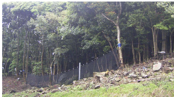
図-4 立木に PE ネットを支持させた事例 (仮設安全対策)
