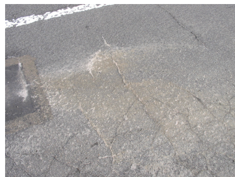
写真-2 橋面舗装の状況
