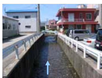
写真(4) コンクリート護岸
