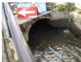
写真(1) コルゲートパイプ
