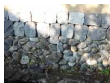
写真(2) 武家屋敷周辺の石積み護岸
