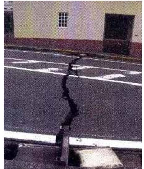
写真-1 アスファルトの亀裂
