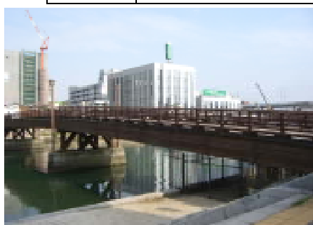
写真-1 T橋全景
