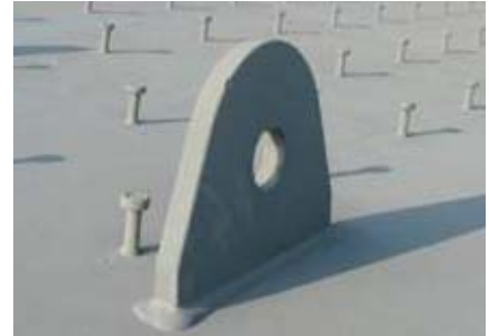
図-1 吊りピースとスタッドジベル
