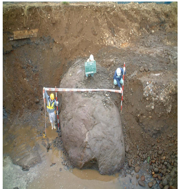
写真-1 河川敷内の掘削にて出現した転石
