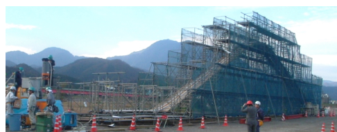
写真-1 グラウト試験体
