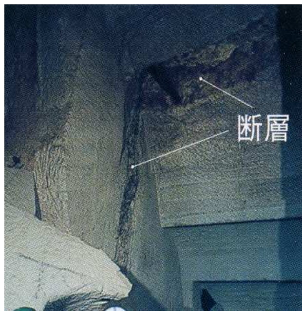
図-1 現場地下付近の空洞内の写真
