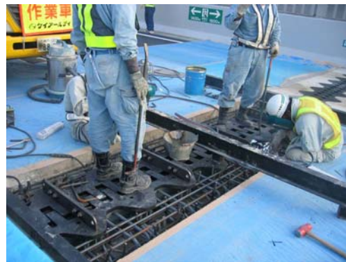
写真 2 伸縮装置の取替え工事
