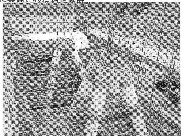
写真-3 二重管格点構造
